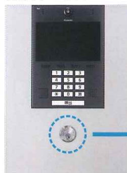
インターホン集合盤に キースイッチを設置した施工例
