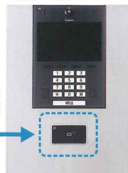
インターホン集合盤に FRS-A*3を設置した施工例
